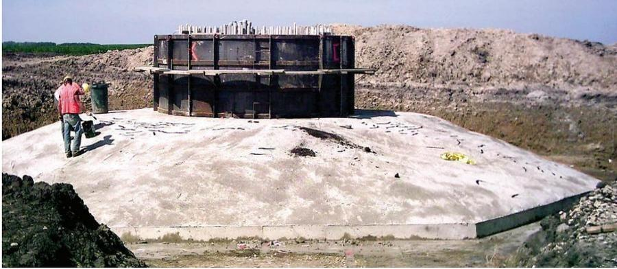
شكل 3-4- مثال لأساس التوربينات الهوائية
