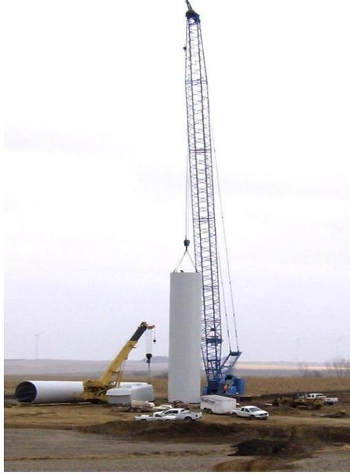
شكل 3-5- رافعة مجنزرة تستخدم في أعمال تركيبات أبراج التوربينات الهوائية
